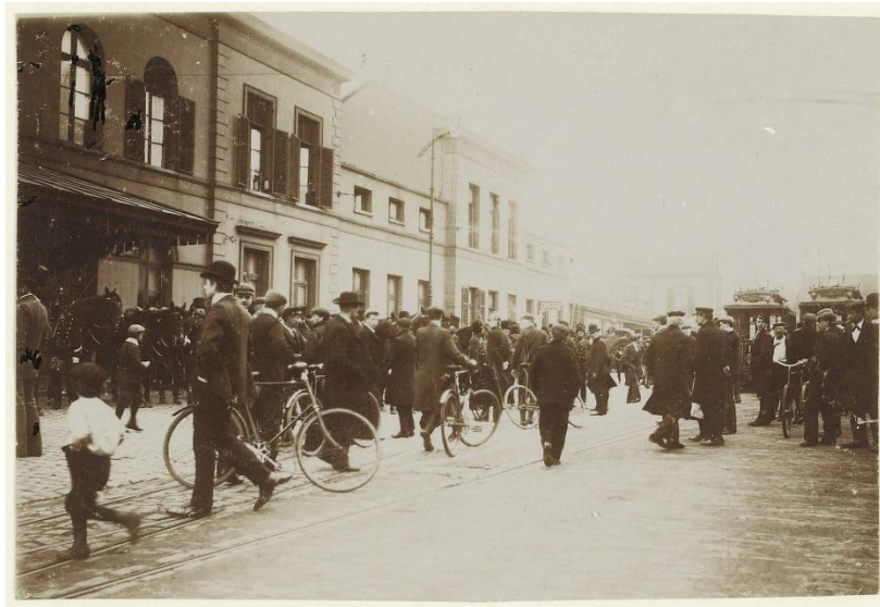
Staking in Haarlem. De Algemene Spoorwegstaking in 1903 leidde tot de oprichting van de eerste moderne vakbeweging, de NVV, in 1906.
